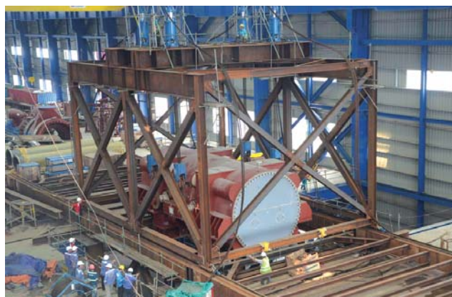
Các cán bộ, kỹ sư PVC-MS đang lắp dựng cụm máy phát Tổ máy số 2 Nhà máy Nhiệt điện Thái Bình 2. Ảnh: PVC
