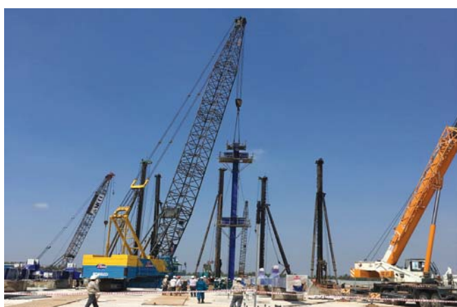
Lễ khởi công lắp đặt kết cấu thép lò hơi Tổ máy số 1 Nhà máy Nhiệt điện Long Phú 1. Ảnh: Lilama
